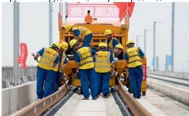
Рис. 13. Строительство железной дороги в Китае
