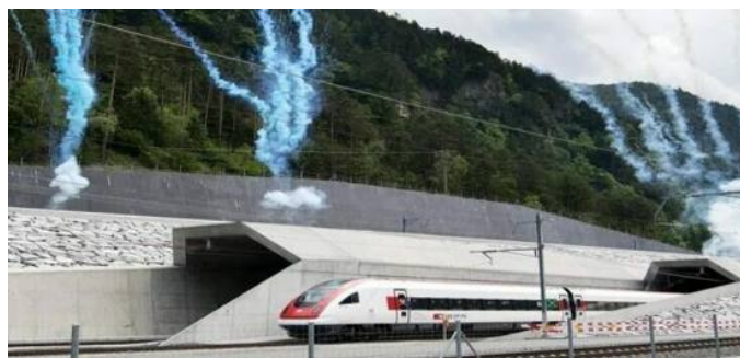
Рис. 7. Готтардский базовый тоннель
