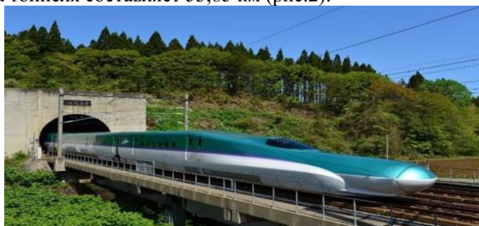
Рис. 6. Японский тоннель Сэйкан
